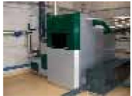
Die beiden HERZ-BioMatic-Anlagen mit einer Heizleistung von jeweils 400 kW sind mit einer eigens für die Anlage konstruierten Aschenaustragung ausgestattet.
