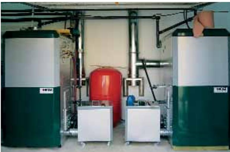
Die aus kleinen Chalets bestehende Appartementanlage Lachat wird mit zwei 90 kW-HERZ-Anlagen zentral mit Wärme versorgt.
