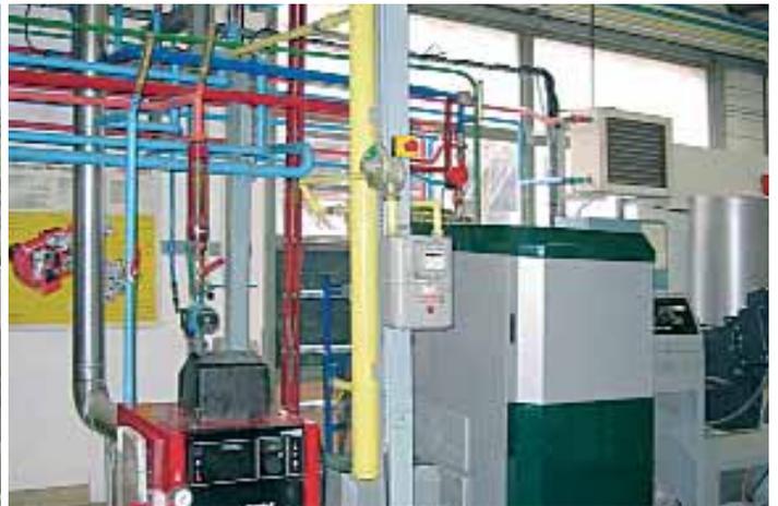
Am Lycéé Amberieu, einer Fachschule für Installateure, üben die Schüler direkt am Objekt das Installieren, Einstellen und Warten einer Heizungsanlage. Neben Öl-, und Gaskesseln ist hier eine HERZ-Hackschnitzelanlage (25 kW) in Betrieb.
