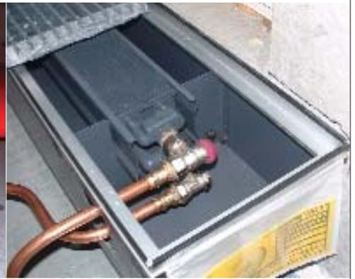
Die Voreinstellung in den Bodenkonvektoren erfolgt mittels HERZ-Feinstregulierventilen und HERZ-RL-5-Rücklaufventilen
