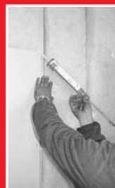
Rozstupy medzi profilmi zodpovedajú použitej platni stenového vykurovania.
