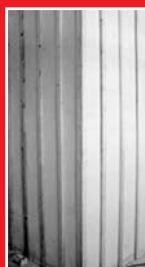
Rozstupy medzi profilmi zodpovedajú použitej platni stenového vykurovania.
