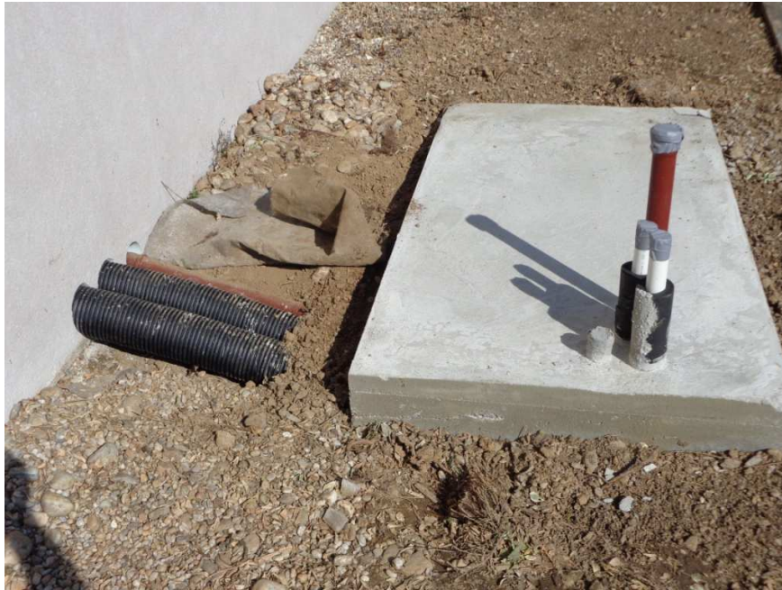
Obr. 5.2: Celoplošný betónový základ
