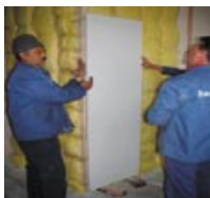
Osadenie HERZ panelov.
