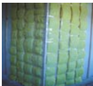
Teplná izolácia vložená medzi profily. Hrúbka daná teplotným výpočtom.
